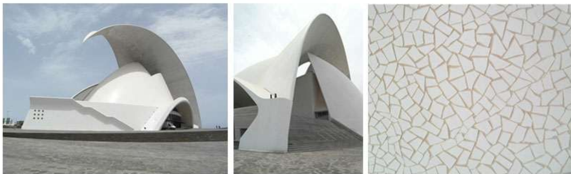
Obr. 12-14: Santiago Calatrava – auditorium na Tenerife (1991-2003), Španělsko. (zleva doprava) celkový pohled / bližší záběr na ohnutou skořepinovou střechu, jejíž tvar se díky perspektivě výrazně mění. Budova je stále se proměňující abstraktní skulpturou / detail obložení skořepinové konstrukce.
